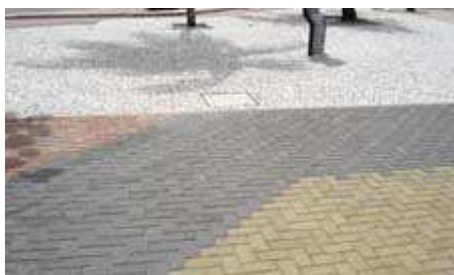
Pisos intertravados coloridos substituem as antigas pedras portuguesas das calçadas.
